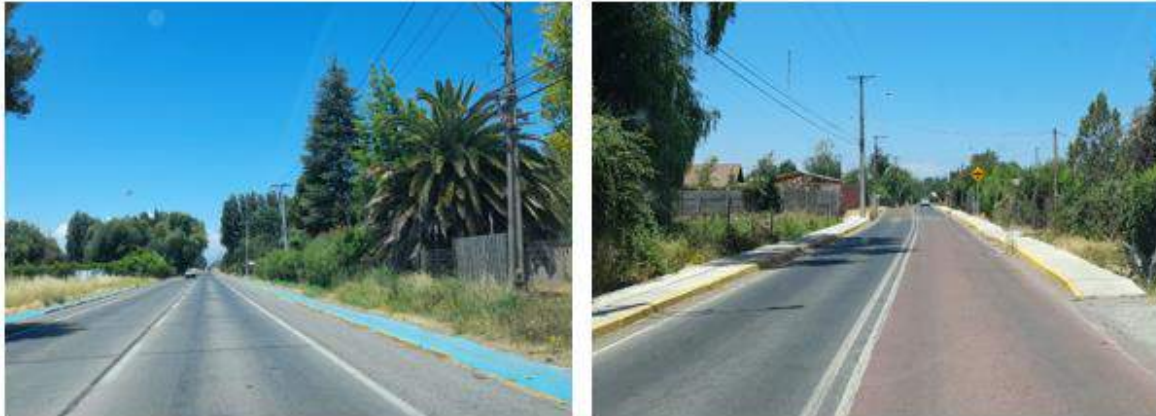
Ilustración 26 y 27: Ciclovía en ruta J-60 y obras de veredas y seguridad vial en la ruta J-470 sector El Llano.
