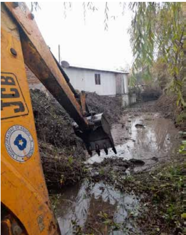
Limpieza Sector el Llano Pedro Luis Molina Zona Contigua a Viviendas
