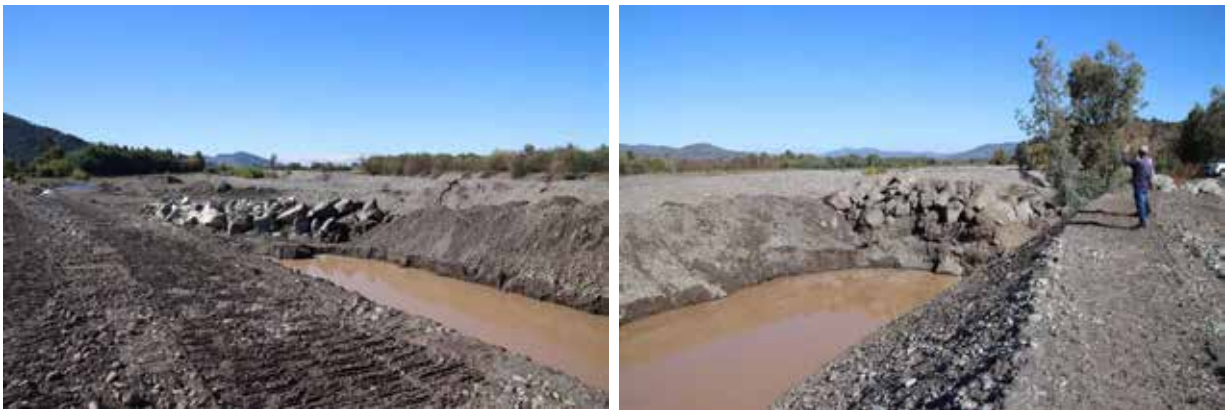
Imagen referencial – Obras de Defensa Fluvial y Encauce – Sector Majadilla
