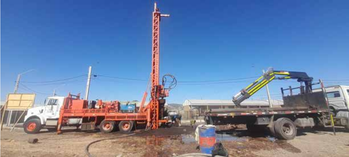
CONSTRUCCION POZO PROFUNDO QUICHARCO
