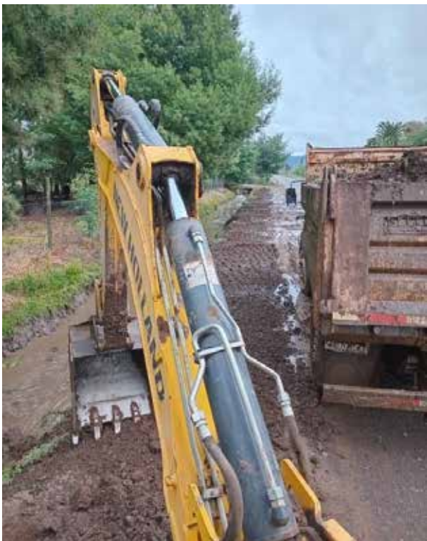
Limpieza desagüe Palquibudi El Corazon Zona contigua a Viviendas
