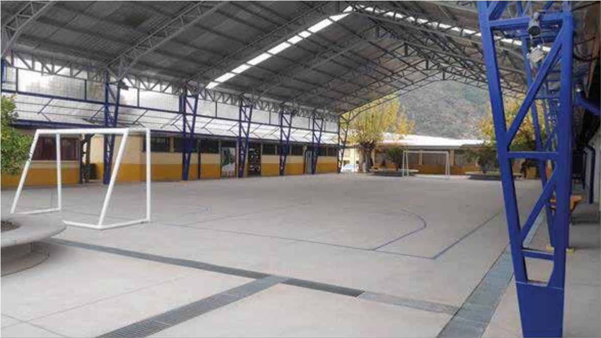
CONSERVACIÓN INFRAESTRUCTURA DEPORTIVA ESCUELA RAUCO
